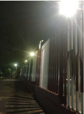
Sustitución de reflectores, 2025.
