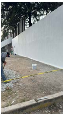
Levantamiento de muro perimetral, 2025.
