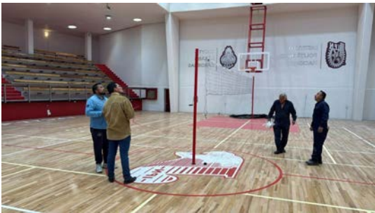
Remodelación de edificio de gimnasio, 2025.
