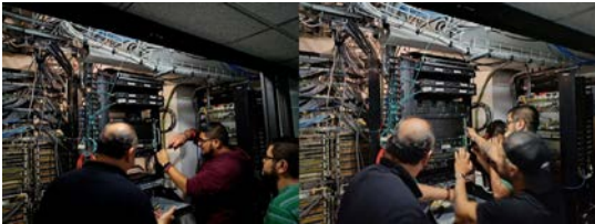
Retiro de router S3 dañado (izquierda) e instalación de equipo de ruteo S4 donado por ESCA Santo Tomás (derecha), septiembre del 2025
