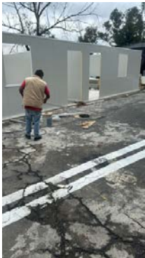
Instalación de aulas prefabricadas, 2025.
