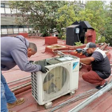
Mantenimiento correctivo del aire acondicionado del site Principal, mayo del 2025.
