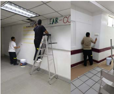
Diversos mantenimientos a la infraestructura.
