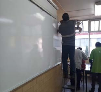
Personal instalando pizarrones y ventiladores en todas las aulas del plantel como parte del programa “La Escuela es Nuestra”.
