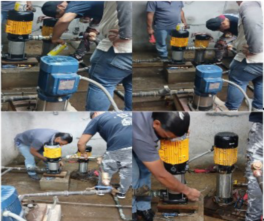
Cambio de bomba para el suministro de agua potable y reemplazo de tubería y válvulas dañadas.
