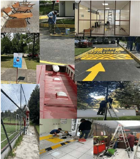
Mantenimiento de la infraestructura física del CICS UMA 2025
