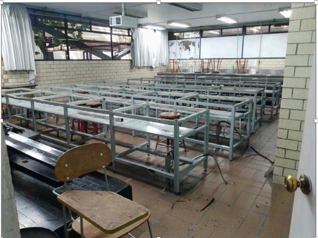
Imagen de los trabajos de rehabilitación de un laboratorio en el Departamento de Botánica en 2025.
