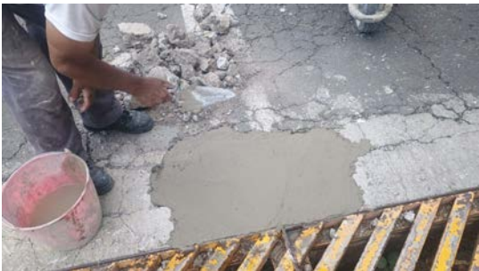
Mantenimiento al asfalto del estacionamiento principal y vías de acceso de la ESCOM.
