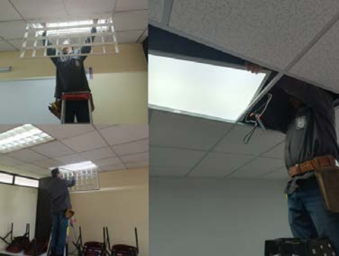
Sustitución de lámparas fluorescentes por led.
