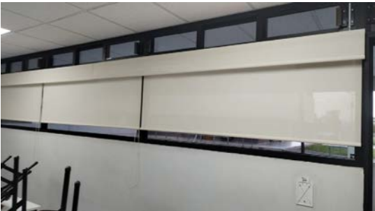
Instalación de persianas en aulas y laboratorios del edificio 5 de la ESCOM.
