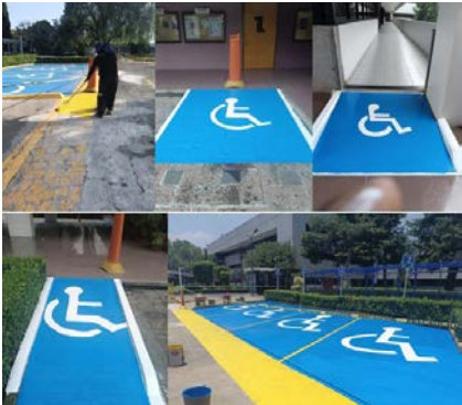
Mantenimiento a lugares de estacionamiento y rampas para discapacitados.
