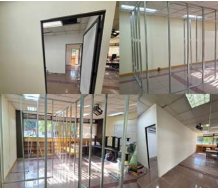
Mantenimiento y adecuaciones en la sala 1002 de la UTEyCV de la ESCOM.
