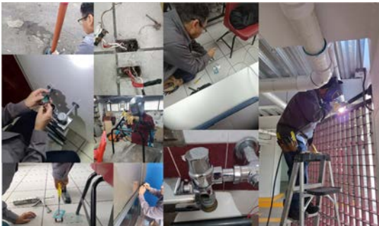
Mantenimiento a instalaciones de la ESCOM.
