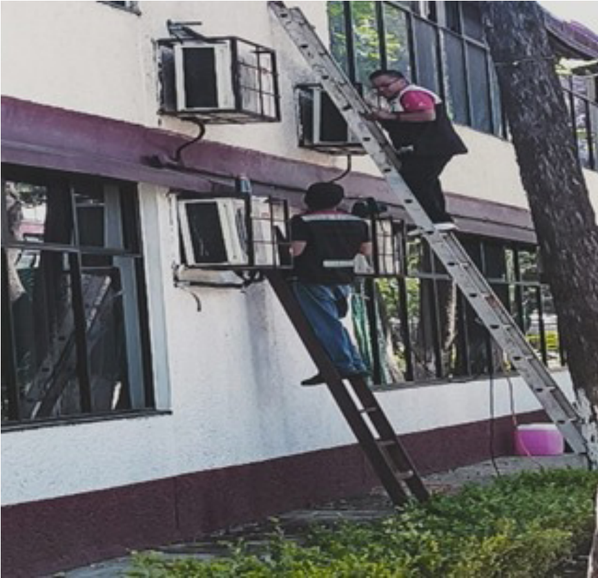
Mantenimiento de aire acondicionado.
