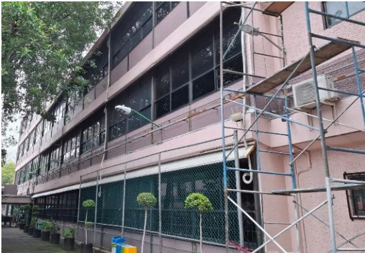
Mantenimiento y pintura de fachada.
