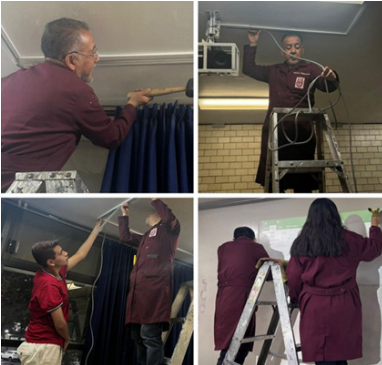
Mantenimiento: resanado, pintado y canalización para cableado HDMI.
