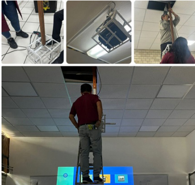
Modificación de bases para videoproyectores y canalización de cableado HDMI.
