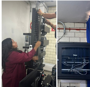
Organización y limpieza integral del SITE de cableado de red.
