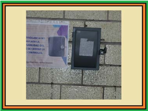
Instalación de una caja de seguridad.
