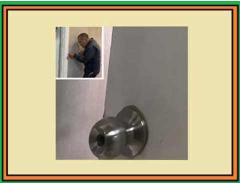
Instalación de una chapa y reparación de la puerta del baño.
