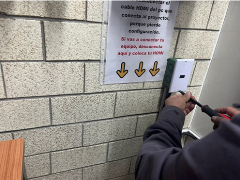
Instalación de placas con sus respectivas cajas para el cableado.
