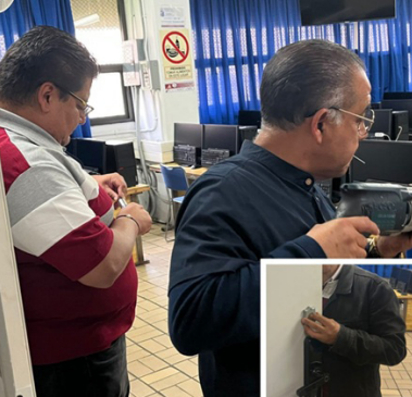
Instalación de una cerradura electrónica en la puerta de la sala de cómputo de Geomática.
