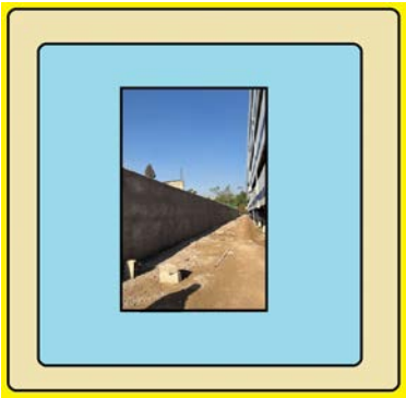
Mantenimiento a barda lateral.
