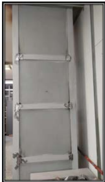
Refuerzo de columnas en el segundo nivel del edificio de laboratorios de la ESIA Ticomán.
