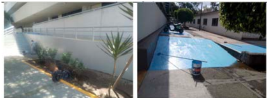
Mantenimiento a pintura de guarniciones.
