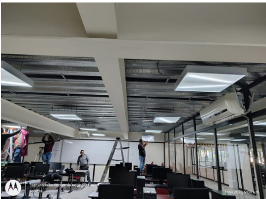
Cambio de luminarias en Laboratorio de Eléctrica-Electrónica.
