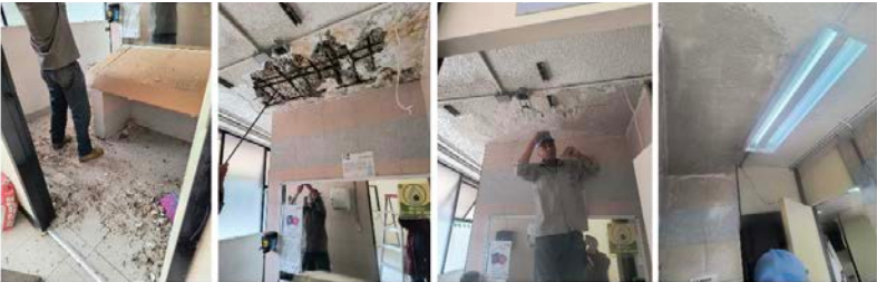
Mantenimiento a sanitarios de mujeres en edificio 3.
