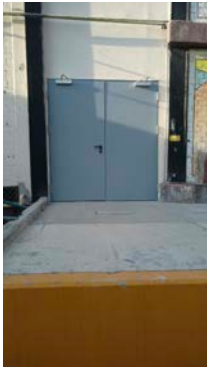
Vista norte del edificio 3, puerta de emergencia.
