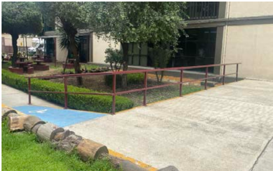
Vista del pasamanos detrás del edificio 4.
