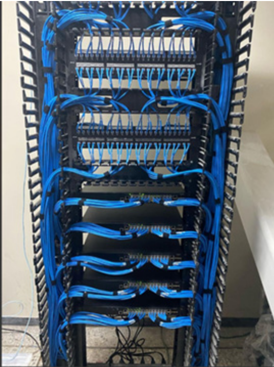
Instalación del equipo de telecomunicaciones.
