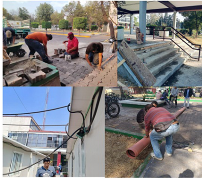
Rehabilitación de instalaciones eléctricas, hidrosanitarias y andadores.
