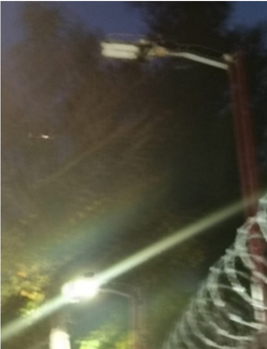
Arreglo de las luminarias.
