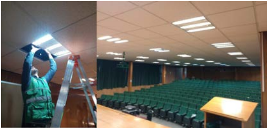
Cambio de luminarias fundidas T-5 de 6 watts 110/220 volts en el auditorio 2 ESIME Zacatenco.
