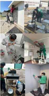
Trabajos de mantenimiento y servicios en la ESIME Zacatenco herrería, carpintería, cerrajería, plomería, electricidad
