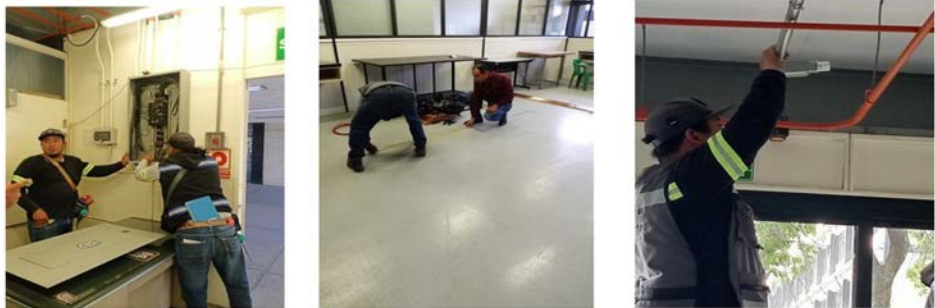
Instalación eléctrica, hidráulica y sanitaria en laboratorio de petroleros edificio Z5 planta baja.
