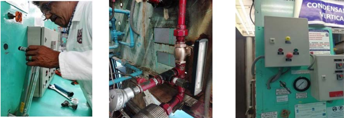
Limpeza en rotámetros sustitución de válvulas, limpiezas en los equipos en operaciones unitarias.
