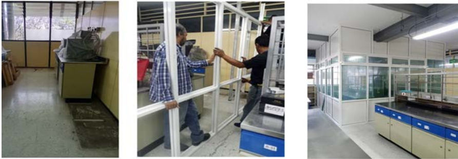
Instalación de cubículo en el laboratorio de polímeros.
