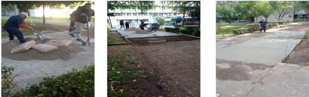
Reparación de piso dañado a un costado del edificio 7.
