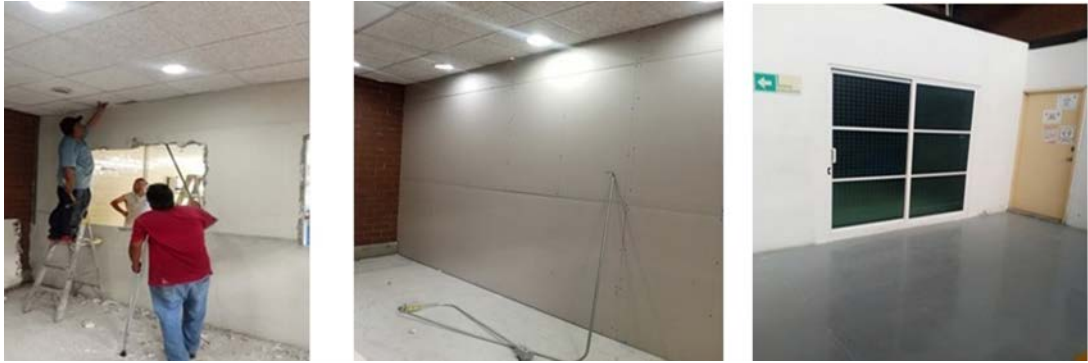
Remodelación en laboratorios de fenómenos de transporte.
