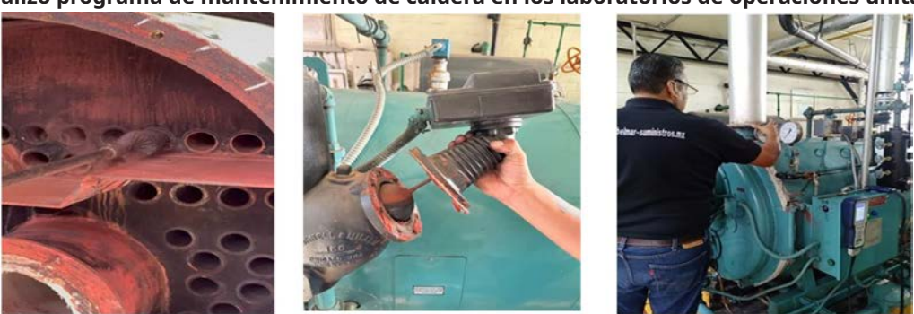
Mantenimiento de caldera.
