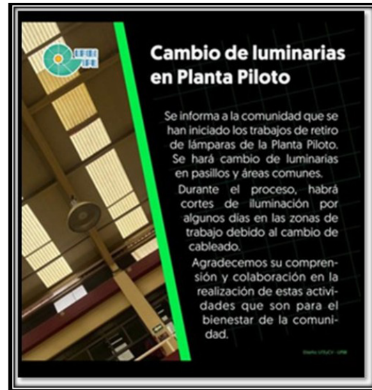
Aviso a la comunidad por el cambio de luminarias en la unidad.
