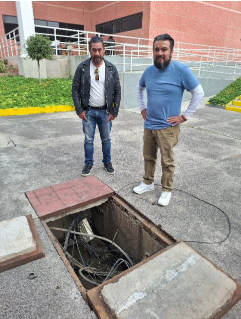
Mantenimiento de fibra óptica.
