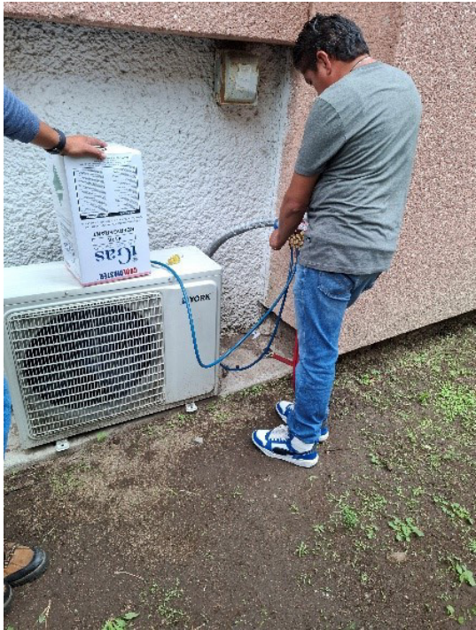
Mantenimiento aires acondicionados.
