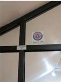
Protección civil. Revisión periódica extintores.
