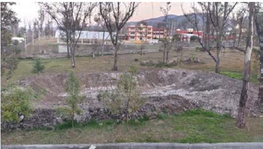
Construcción de olla para captación de aguas pluviales en el CVDR Morelia.
