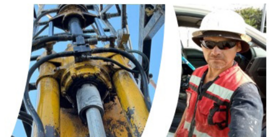
Equipo de perforación para mecánica de suelos.
