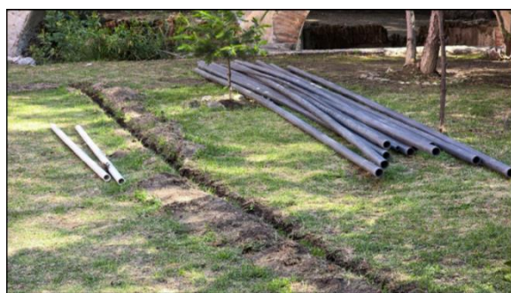
Figura 1.- Primera etapa conexión de salidas de aguas residuales.
