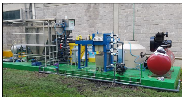
Figura 2.- Instalación del sistema y de los depósitos
